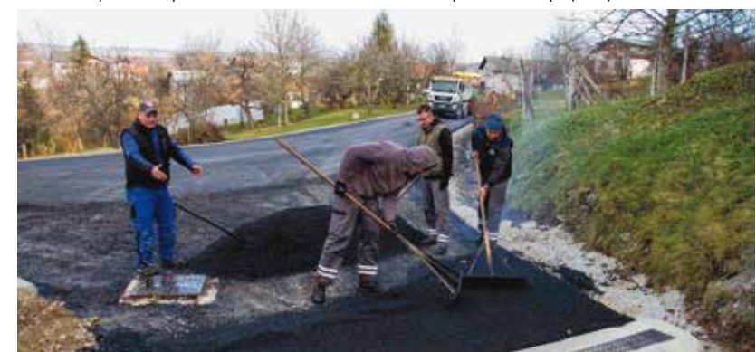
Polaganje finog asfaltnog sloja na 400 metara od Vukovićeve do Matišića
