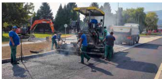
Radovi na asfaltiranju nove prometne površine
