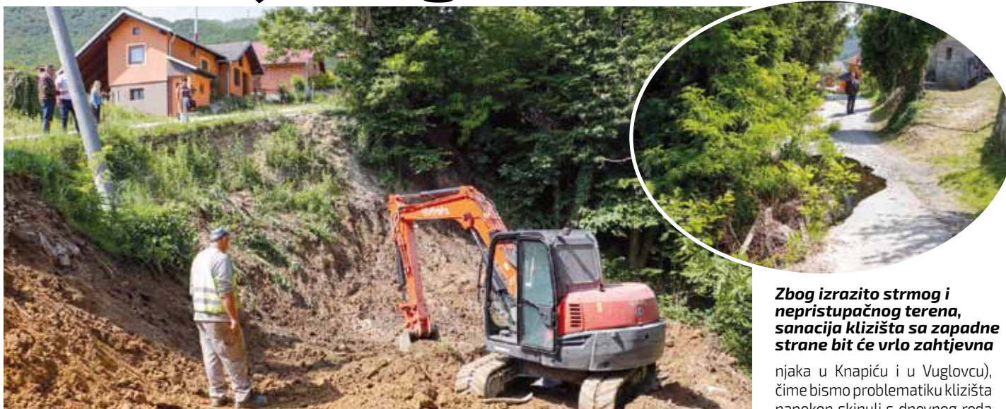
Sanacija se izvodi gradnjom stepenastog nasipa i drenažom terena
