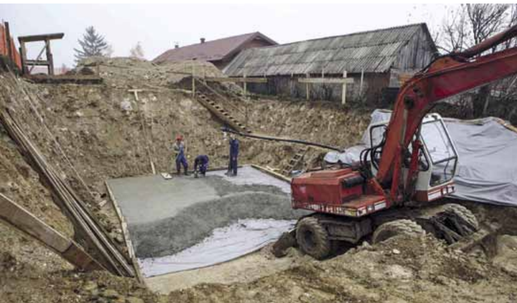
Gradi se vodospremnik kapaciteta 100.000 litara
