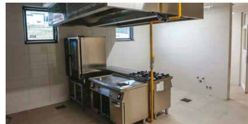
Montaža opreme za vrtićku kuhinju
