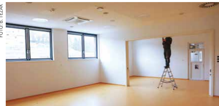
Unutarnji prostori su dovršeni i spremni za montažu opreme
