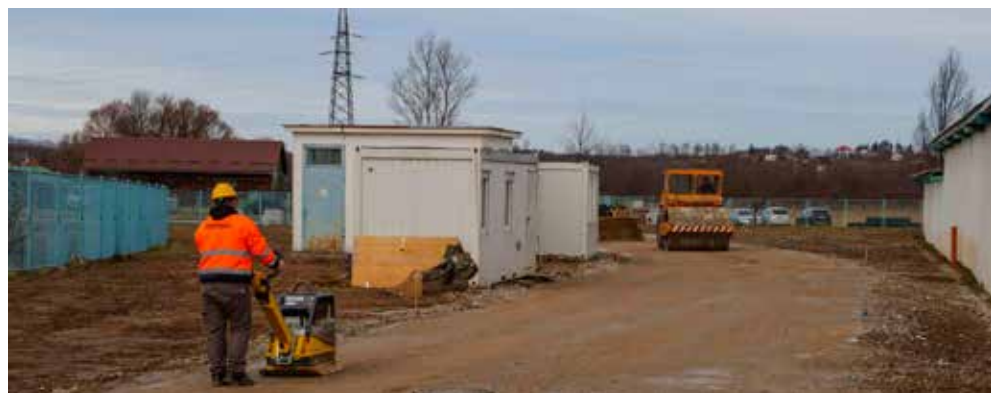
Priprema pristupne ceste za asfaltiranje
