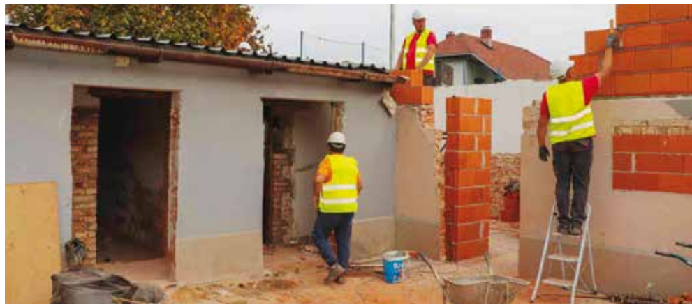
Podižu se novi pregradni zidovi
