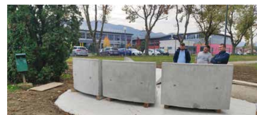
Slaganje i montaža rampi od zaglađenog betona
