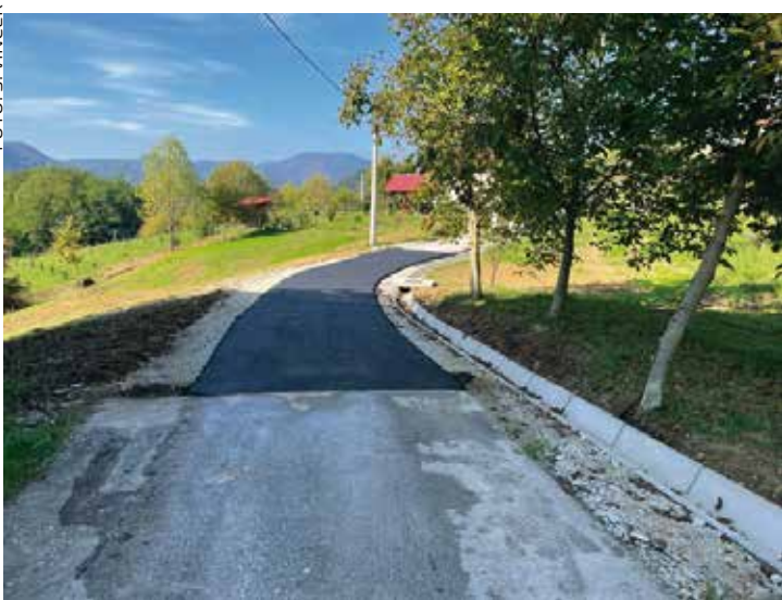
Sanirano klizište na nerazvrstanoj cesti u Osečkoj
