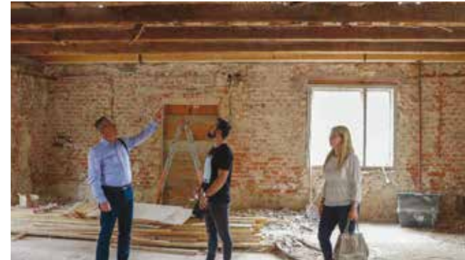
Stara žbuka se odstranjuje, originalna cigla s vanjske strane očistit će se pjeskarenjem
