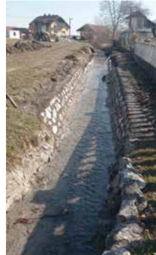
Potočne obale učvršćuju se kamenom
