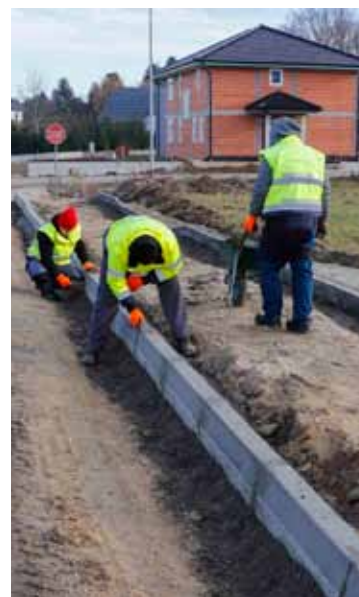
Postavljanje rubnjaka za nogostup u zapadnom odvoju Preradovićeve
