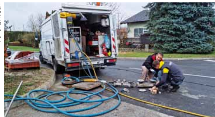
Kumičićevo: Robot s frezom čisti cjevovod
