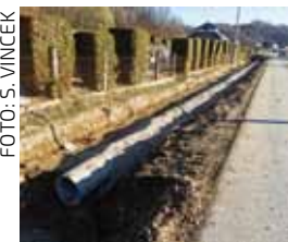
Radovi na zacijevljenju i stvaranju podloge za novo parkiralište
