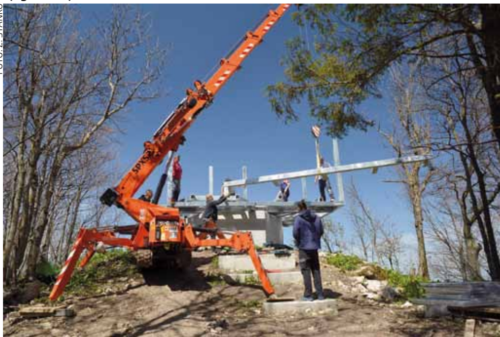
Konstrukcija vidikovca na podlogu je postavljena pomoću dizalica
