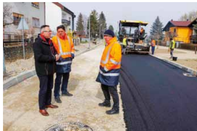
Polaganje grubog asfaltnog sloja u Kumičićevoj ulici
