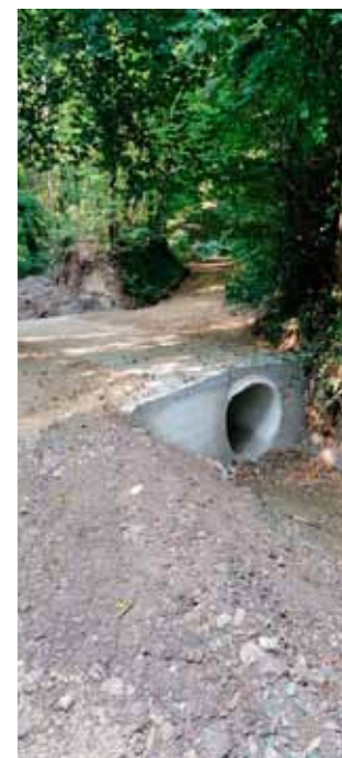
Saniran cijevni propust na potoku u Gečkovcu
