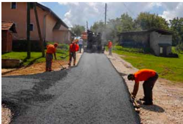
Asfaltiranje dionice u Stažnjecvu
