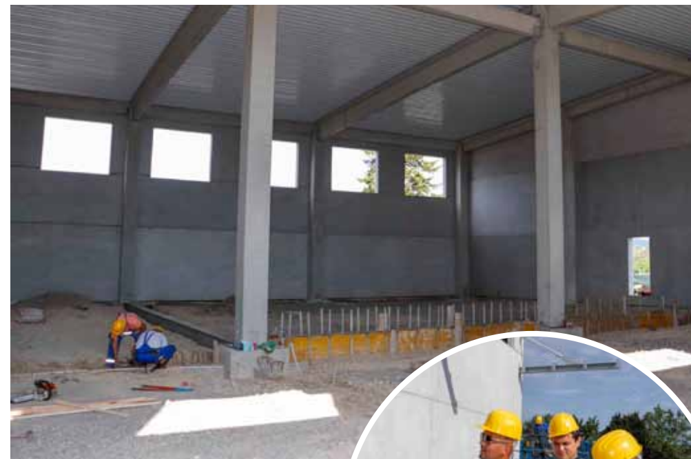
U unutrašnjosti objekta u tijeku su radovi na betoniranju podnih spojnih greda
