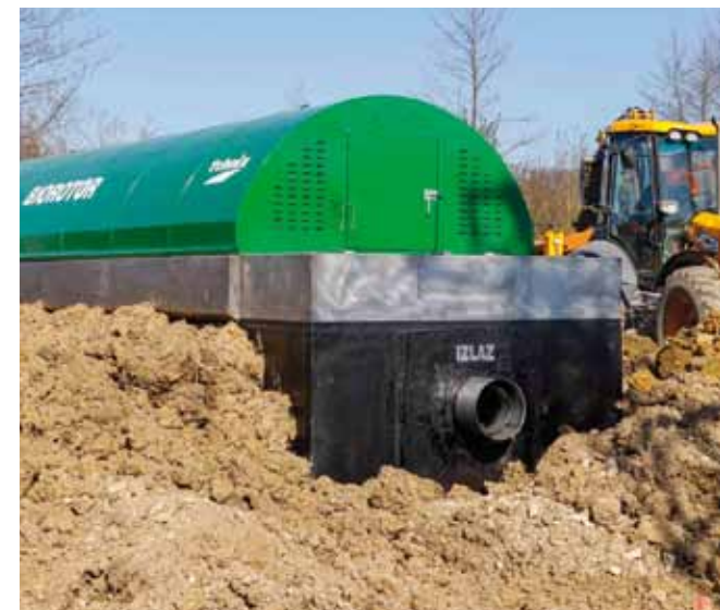
Montaža pročištača za otpadne vode iz sustava Bedenec
