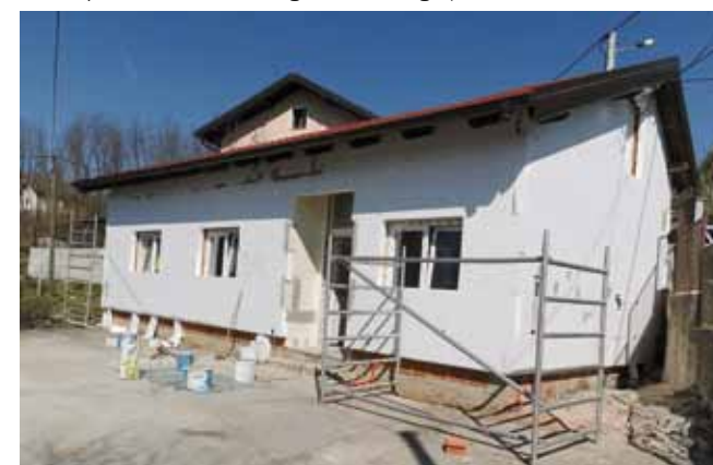
Pripreme za postavljanje termo fasade
