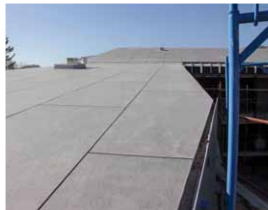
Krov na muzejskom objektu sagrađen je od iternita, tzv. vlaknocementnih ploča za krovove
