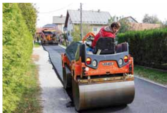
Polaganje asfalta na dijelu Jezerskog puta
